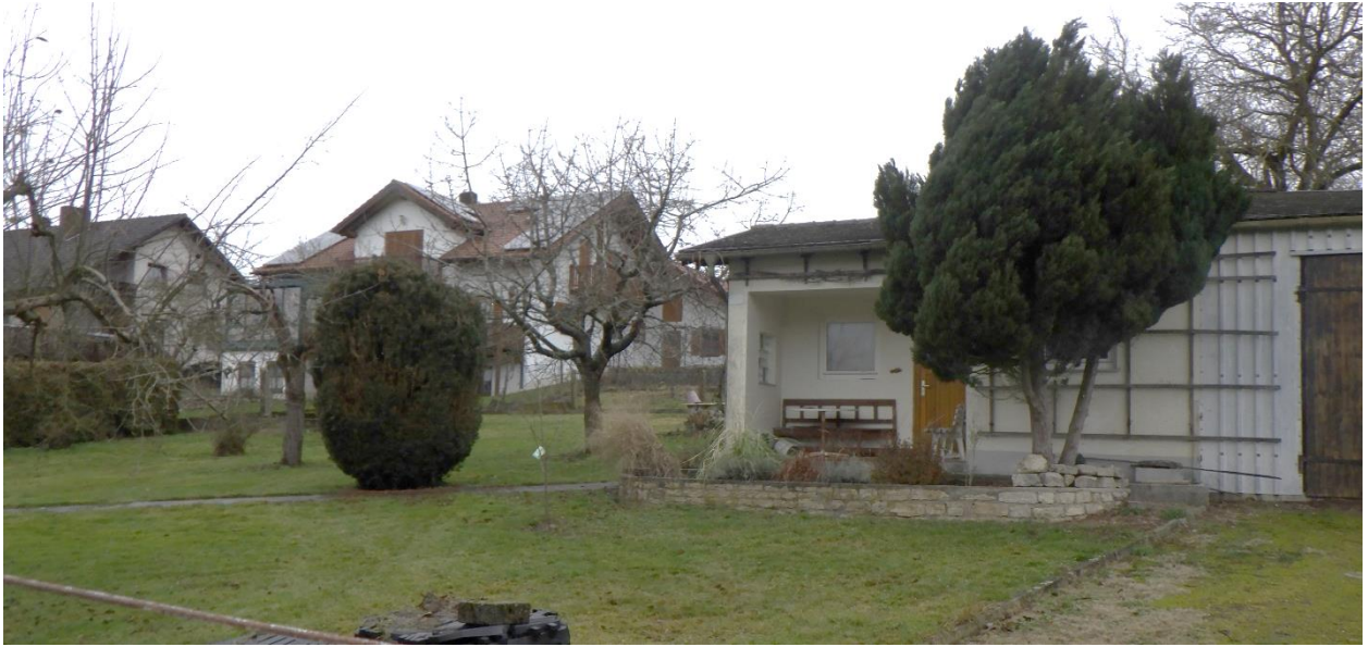
Abb. 5. Blick auf Wohngebäude
