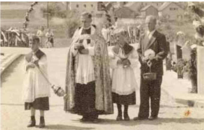
Einweihung der wieder errichteten Brücke 1949
